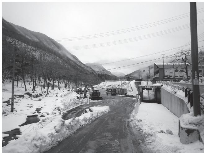
雪のなか第二駐車場の復旧作業に励む(2月6日撮影)
