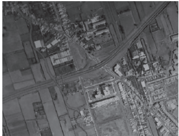
写真 1a 高速道路貫通部
