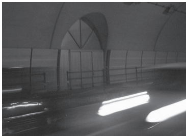
天崎鍾乳洞洞口トンネル内に開口
