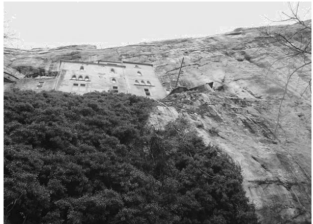
写真1 断崖直下の関係者用駐車場から眺めた教会 建物の右側からリフト用のハンガーが出ている
